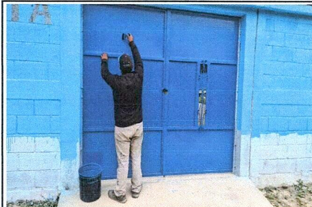
Foto 4: SUSTITUCIÓN DEL PORTÓN.
