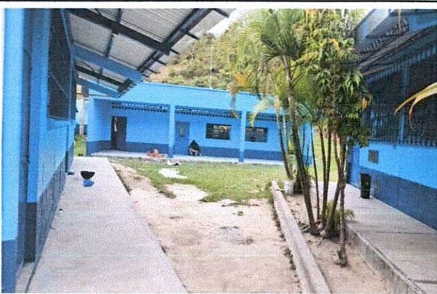
Foto 3: MEJORAMIENTO DE PINTURA INTERNO Y EXTERNO DEL CENTRO EDUCATIVO.
